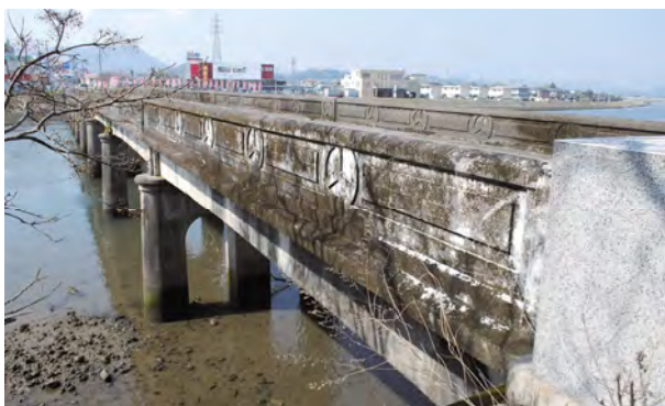
写真-1 現在の始良橋と高欄
