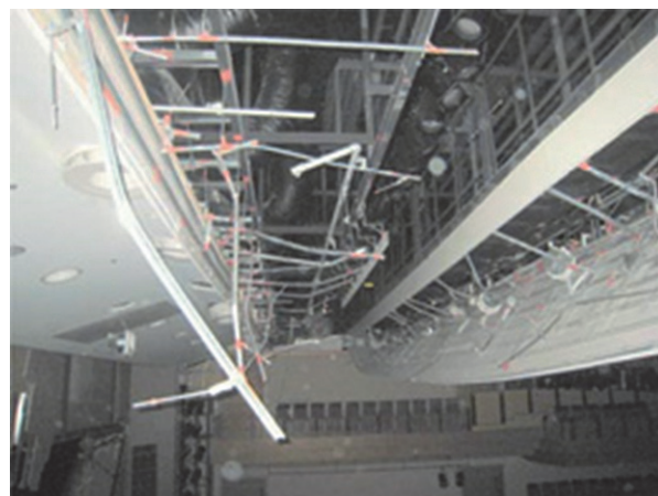
図 2.1 天井の脱落被害
