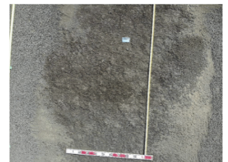
図-4 スケールの設置
