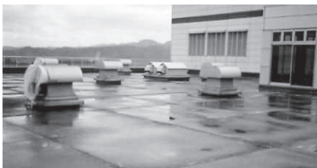
Fig.1 屋上に設置された排気塔
