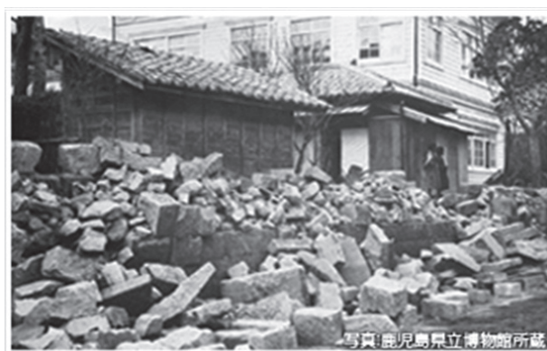
写真 1 鹿児島市内の被害状況
