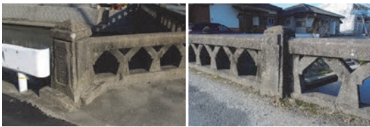
写真-1 直線を多用した毛来橋のデザイン 親柱（左）、中柱（右）とY字型の高欄
