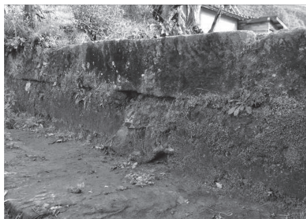
写真-12 側面には用水路に水を供給する為の痕跡
