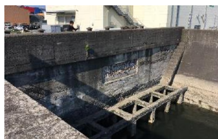
写真-2 木材港水門(下流側)
