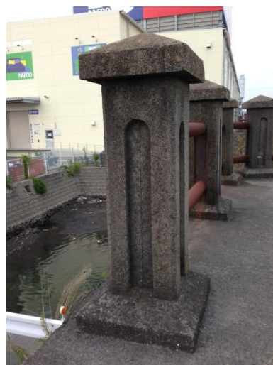
写真-7 高欄柱のデザイン
