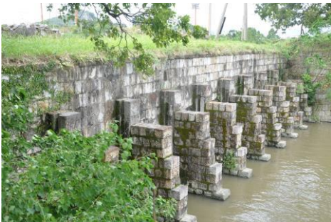
写真-9 群築三番町樋門
