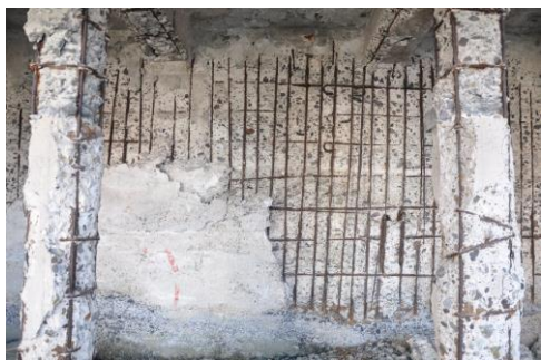
写真-3 水門内部の様子
