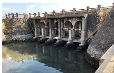
写真-1 木材港水門(上流側)
