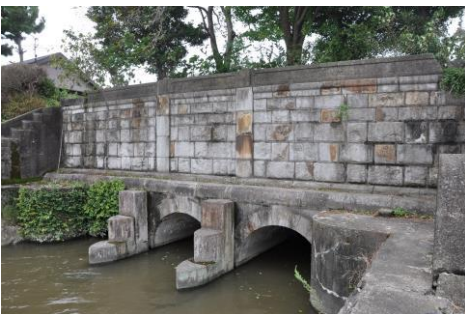
写真-10 群築二番町樋門
