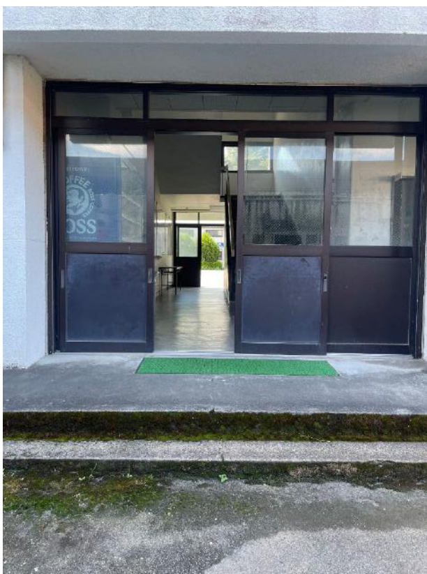
写真-6 4号館裏出入口
