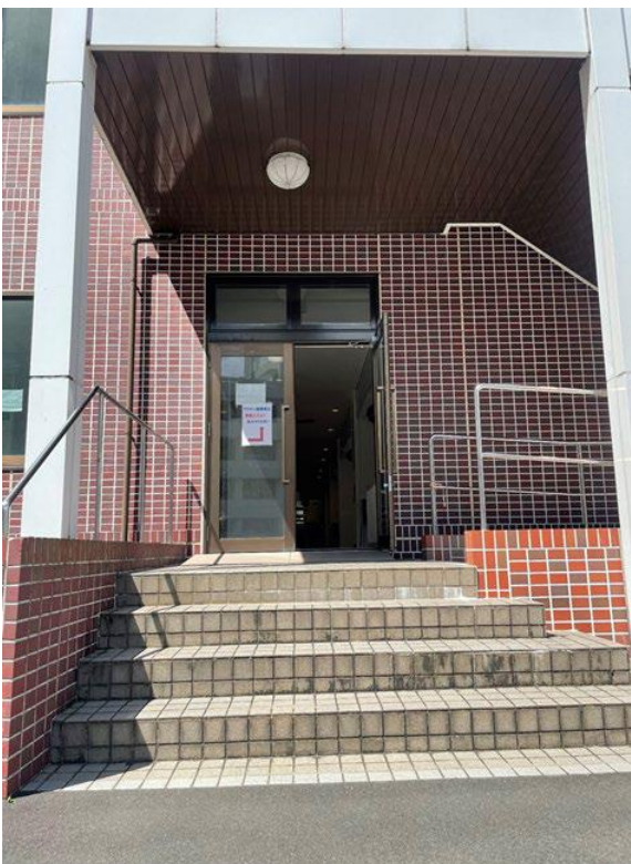
写真-10 厚生会館1階屋外階段
