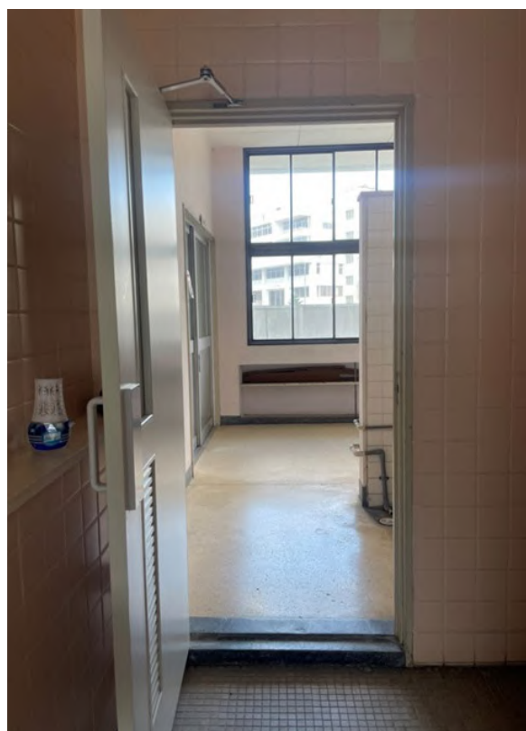
写真-7 2号館1階女子便所
