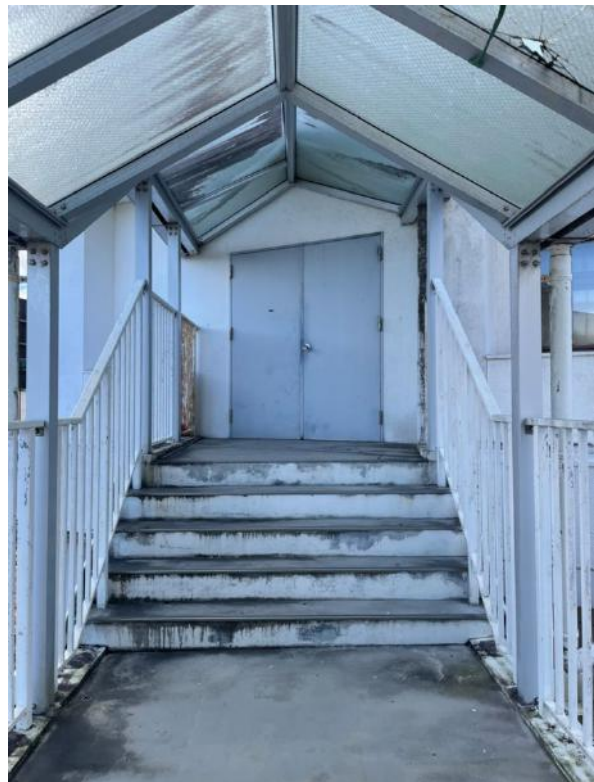
写真-11 渡り廊下(1号館と2号館の間)
