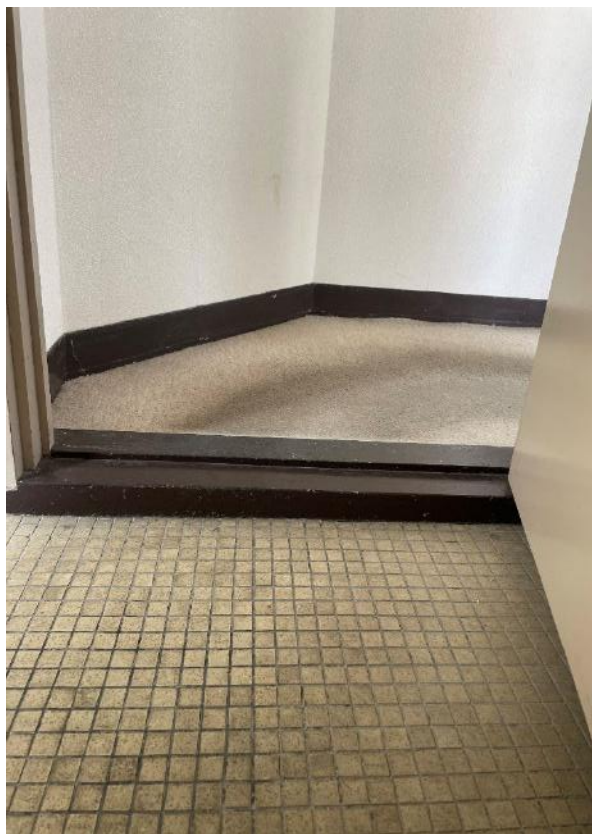
写真-13 9号館1階トイレ入口
