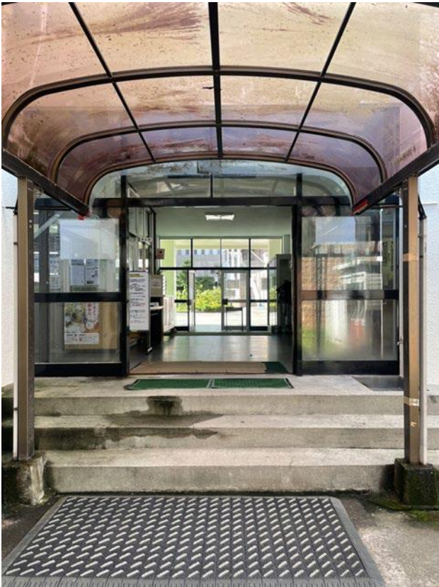
写真-1 1号館裏口
