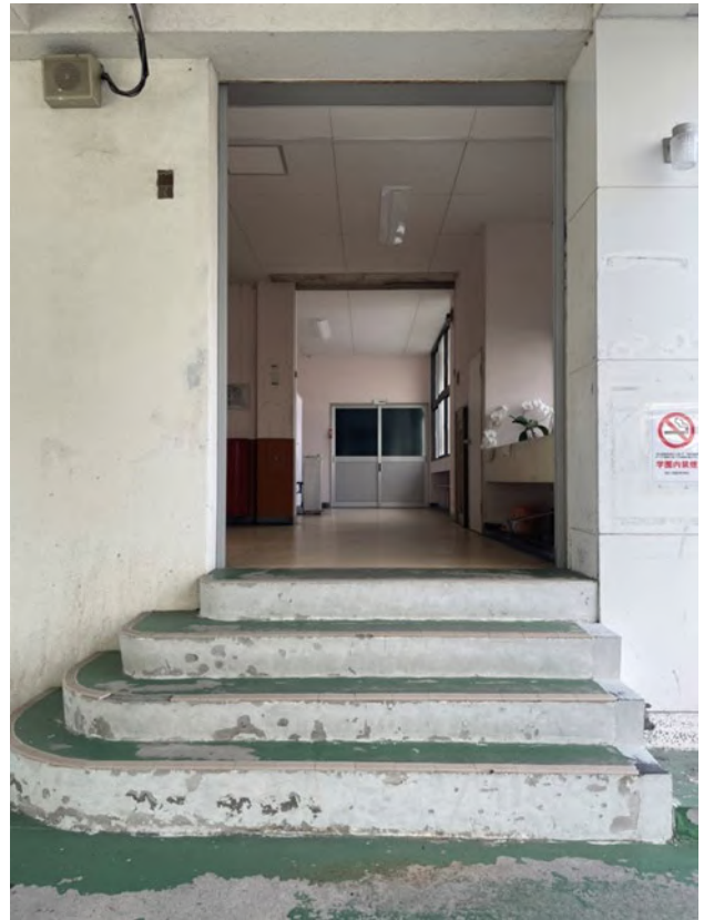
写真-3 2号館1階南側出入口
