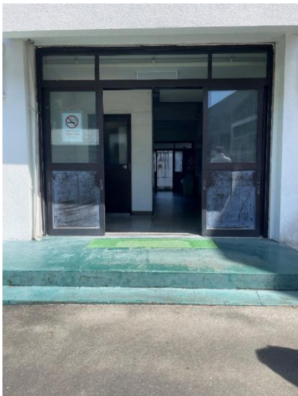
写真-5 4号館表出入口
