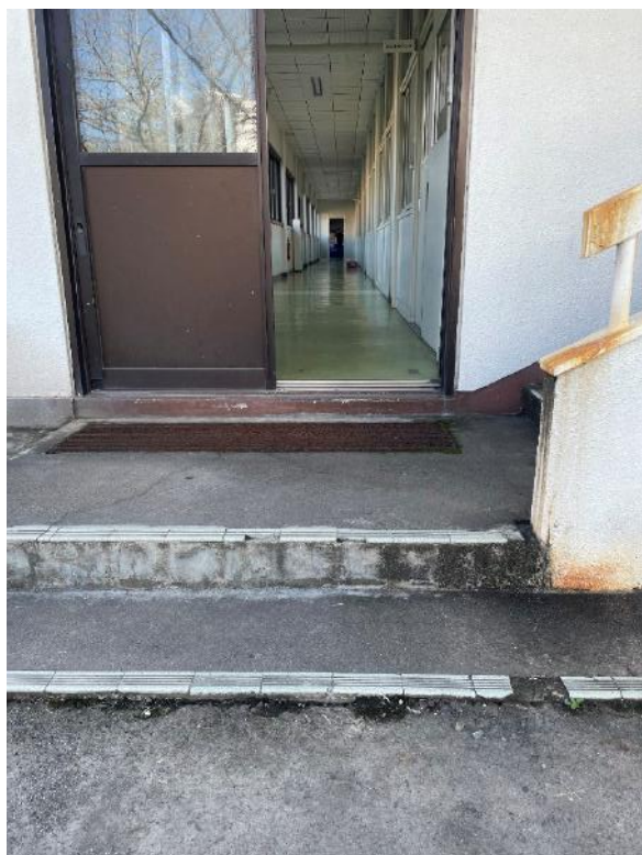
写真-14 4号館1階西側出入口
