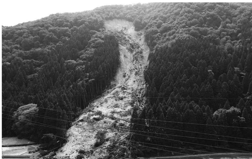
気象条件がよい場合は、小型ドローンによる撮影でも十分な精度が得られる。撮影：Mavic mini12分 点群作成時間15分 (五大開発(株)提供)
