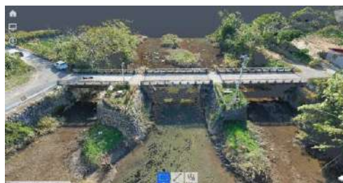
図-1 島津樋門周辺の点群データ
