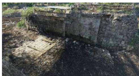
図-3 樋管周辺の状況 (橋梁部除去後)
