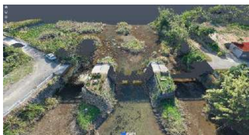
図-2 橋梁部分除去後
