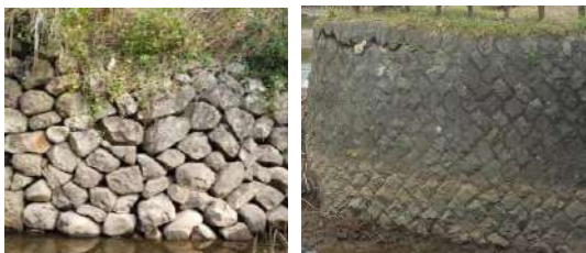
b) 左岸側の石垣 写真-2 樋門周辺の石垣
