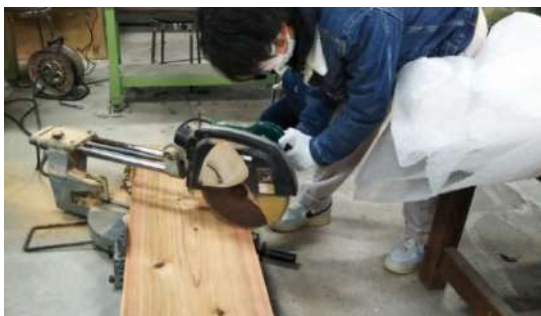
60度カットの切断状況 (写真19)
