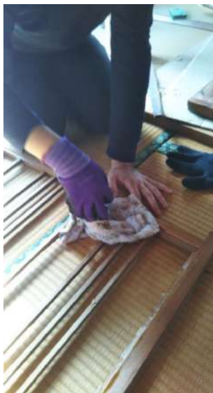
古い障子をはがし状況 (写真13)
