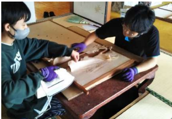
古い障子をはがし状況 (写真12)
