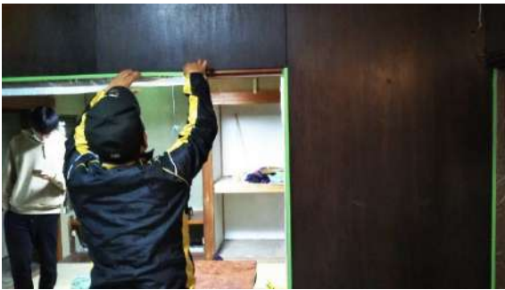
壁・テープ幅150での養生の装状況 (写真6)
