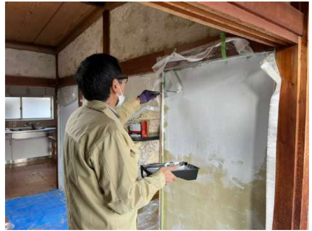
聚楽部分塗装状況 (写真9)
