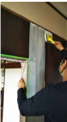
ベニア壁塗装状況 (写真7)
