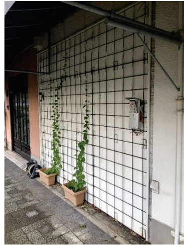
図-2 壁面緑化状況
