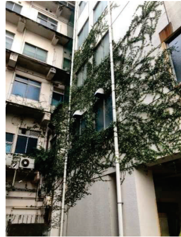
図-9 壁面緑化状況
