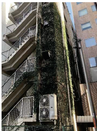
図-14 壁面緑化状況
