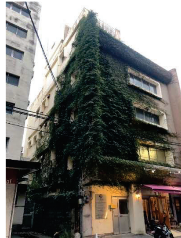
図-10 壁面緑化状況
