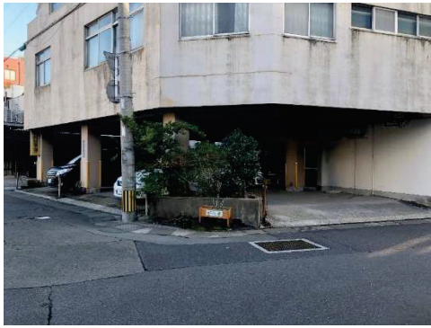
図-5 壁面緑化状況
