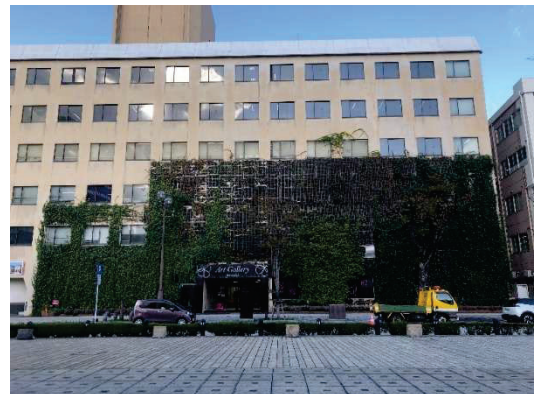
図-3 壁面緑化状況
