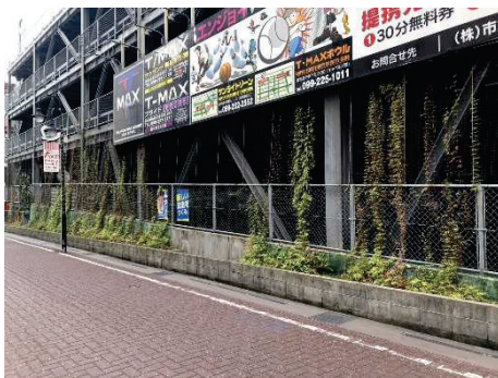
図-15 壁面緑化状況
