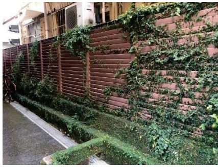
図-12 壁面緑化状況
