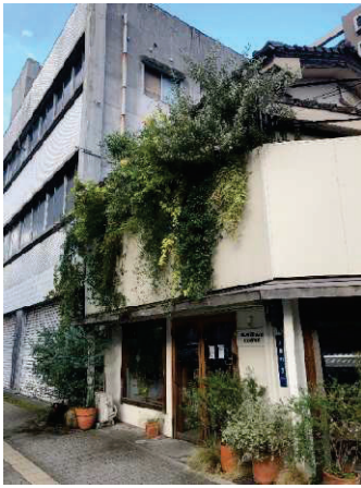
図-6 壁面緑化状況
