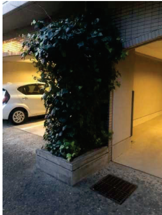
図-13 壁面緑化状況
